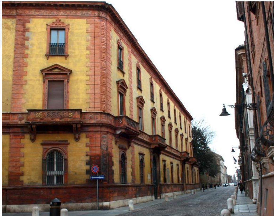
Foto esterna – Via Ercole I d'Este
