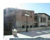
RISTRUTTURAZIONE EX ASILO Fluminimaggiore (CI)
