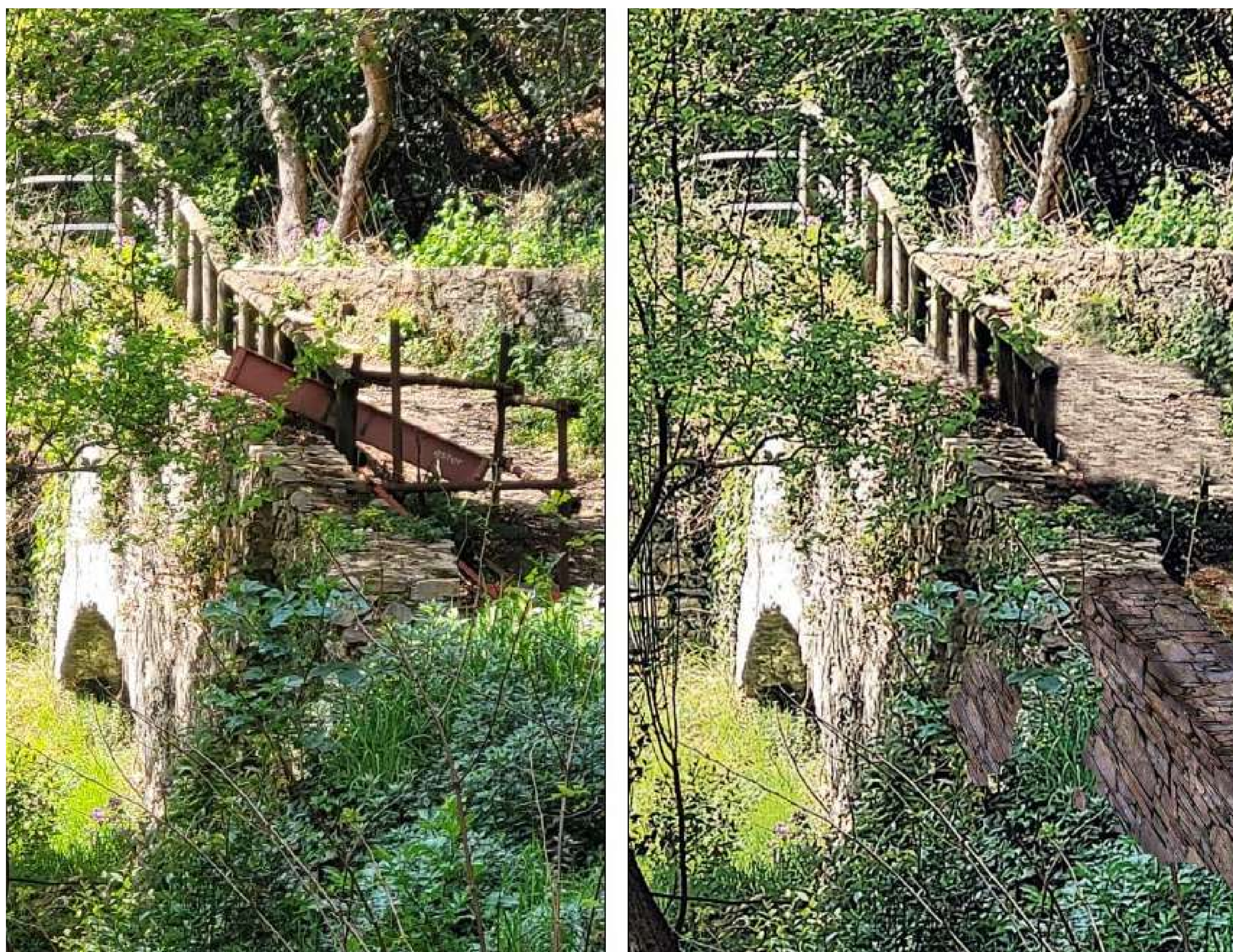
Ricostruzione parziale delle due arcate di Acquedotto con sottomurazione in pietra e cemento.
