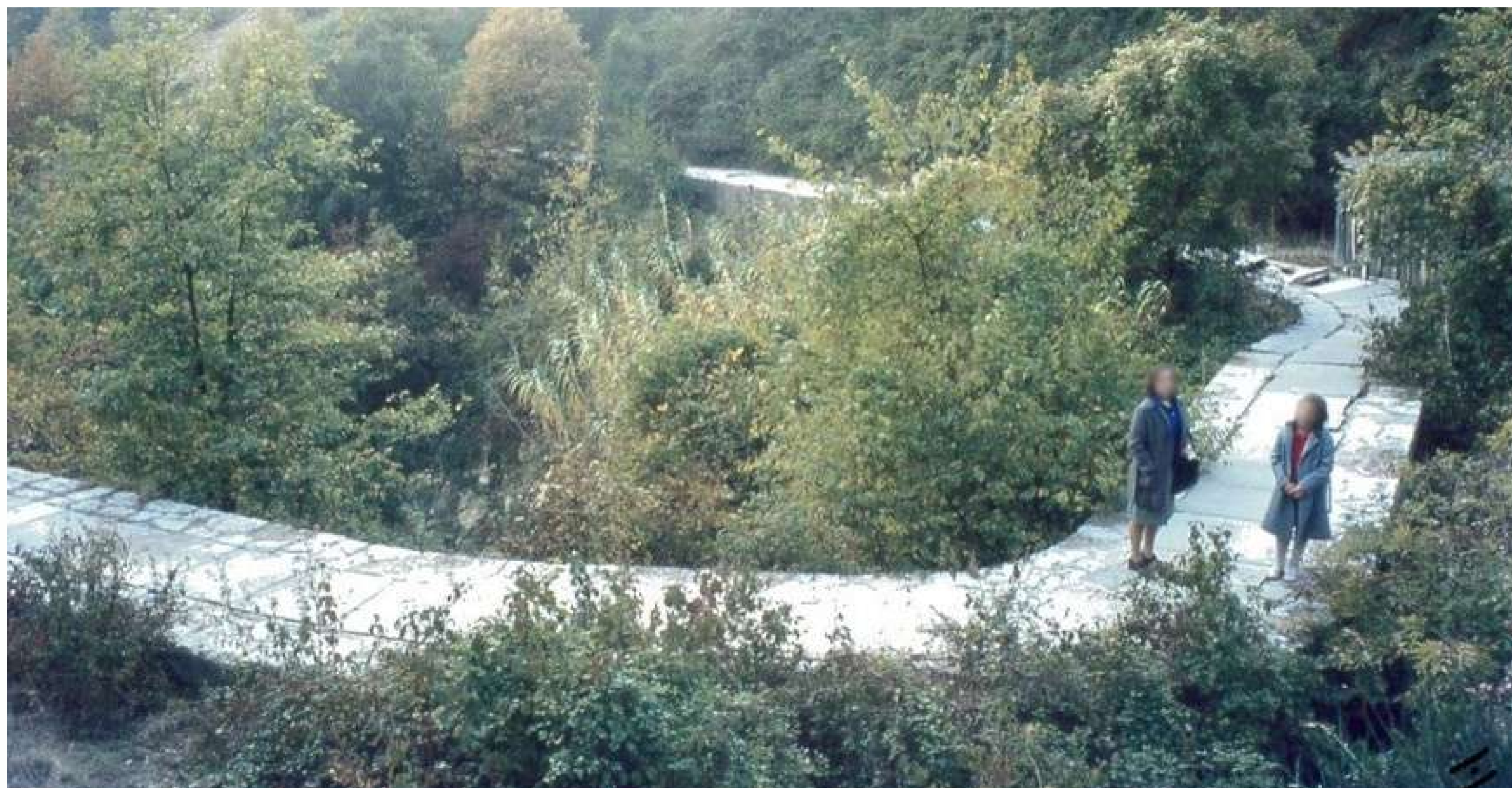
1978: il tratto di Acquedotto che attraversa il rio è ancora intatto.
