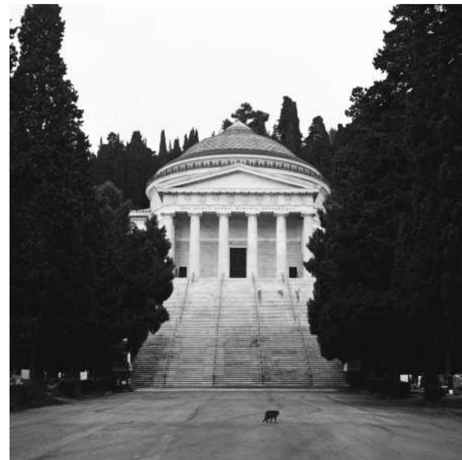
Il Pantheon del cimitero monumentale di Staglieno Restauro realizzato da GERSO, 2000 - 2004
