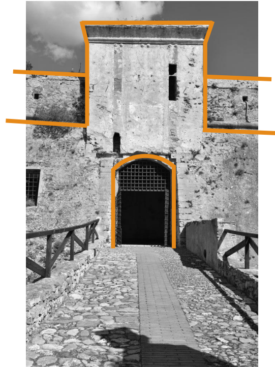
Analisi del portale del Forte Castelfranco poco distante
