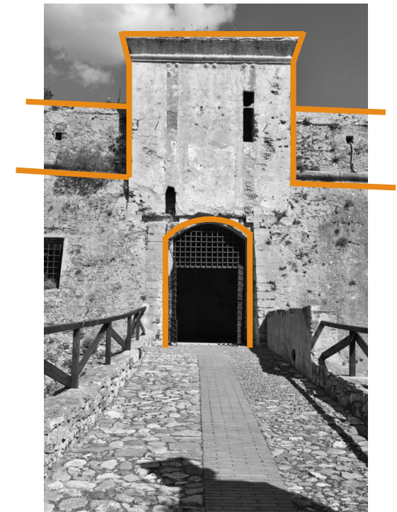
Analisi del portale del Forte Castelfranco poco distante
