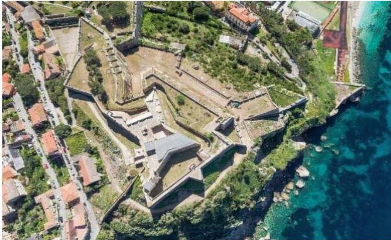
Forte Falcone e bastioni limitrofi e parte del "fronte d'attacco verso terra" – post-operam
