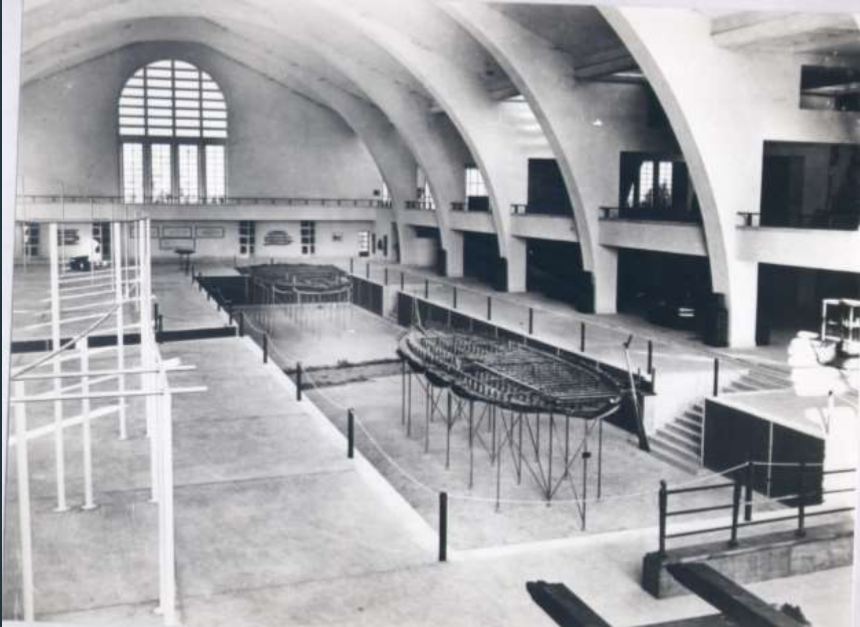
La ricostruzione 25 novembre 1953
